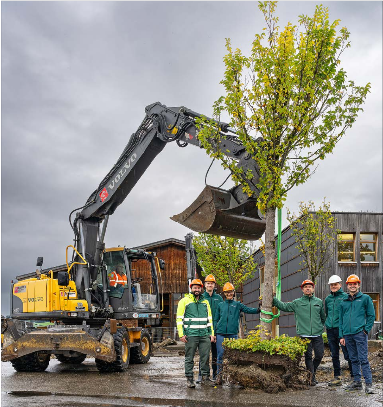
Die drei Ulmen werden umpflanz, um den Büro-Erweiterungsbau zu ermöglichen. Ihre Umsiedlung steht für den Spatenstich und symbolisiert zugleich das kontinuierliche Wachstum der Firma und ihren Erhalt als festen Teil des Firmenareals: (von links) Thomas Schürmann (Bauleiter), Ruedi von Moos (Abteilungsleiter Fensterbau), Eveline Jenni (Architektin), Severin Haupt (Geschäftsleiter), Urs Aregger (Abteilungsleiter Holzbauarchitektur) und David Fischer (Abteilungsleiter Stv. Holzbau). Foto zVg
